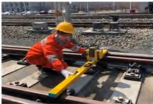
68 图 3-47 轨距测量仪器操作
