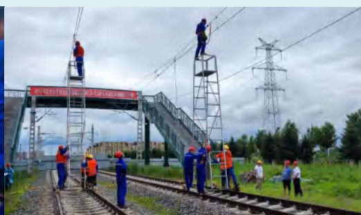
接触线中心锚结安装赛项现场
