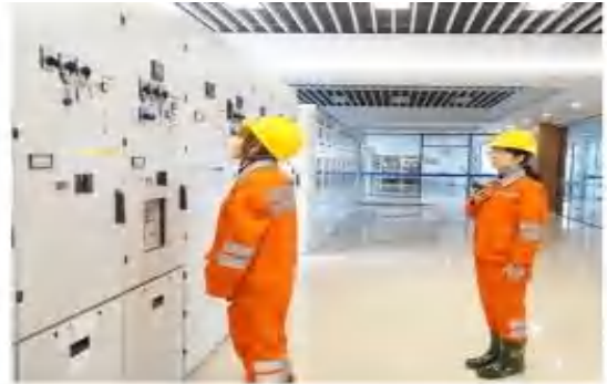
69 图 3-48 三工位开关倒闸操作过程
